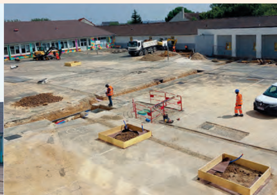
École élémentaire Paul-Painlevé. Des tranchées ont été creusées pour permettre de rénover le réseau de chaleur. Les fosses des futures plantations ont été préparées.
